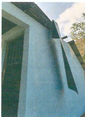
Foto 1: MEJORAMIENTO DE TECHO A LAMINA TROQUELADA CALIBRE 26 Y MANTENIMIENTO DE ESTRUCTURA PORTANTE
